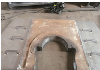
图5 二冲程船用柴油机的机座单片焊接
