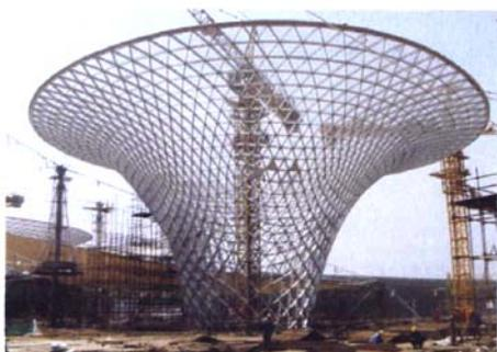
图2 3号阳光谷钢结构构件撤除支撑后实体照片
