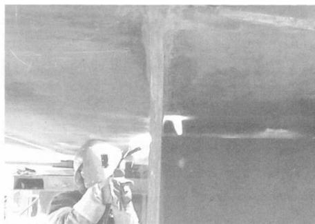
图 2 返修焊随热随焊工艺实施现场
