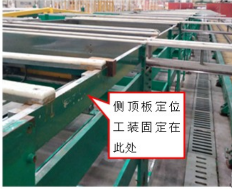
图4 波纹板缝焊平台
